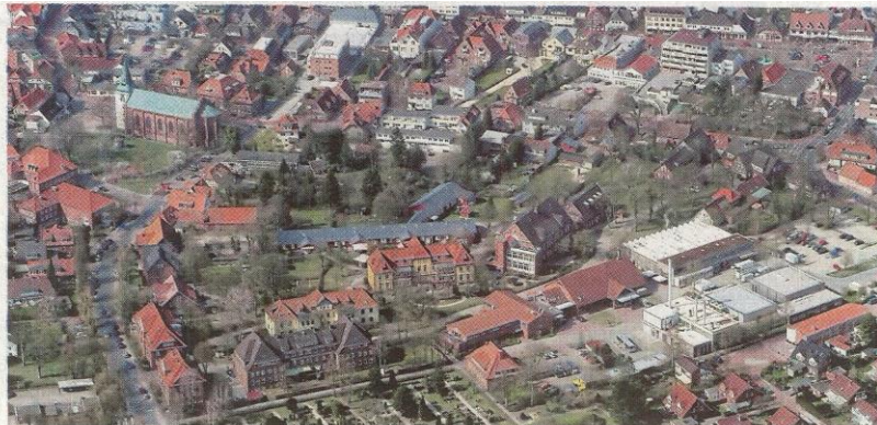
Das Luftbild aus dem Jahr 2015 zeigt das Kerngelände der Werke noch mit dem Bethel-Haus (links, gelb) und der Wäscherei im rechten mittleren Bereich. Diese Gebäude verschwinden beziehungsweise sind schon abgerissen. FOTO: BRUNIES
